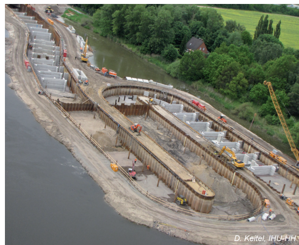
Obr. 4.4-2: Jez Geesthacht, pravý břeh, stavba druhého rybího přechodu (červen 2010), km 586
