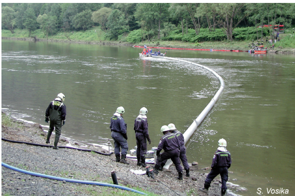
Obr. 5.3-1: Česko-německé havarijní cvičení v hraničním úseku Labe (km 729,5) dne 19. 6. 2004
