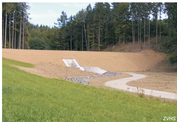
Obr. 6-2: Suchá nádrž Čermná II v povodí Orlice
