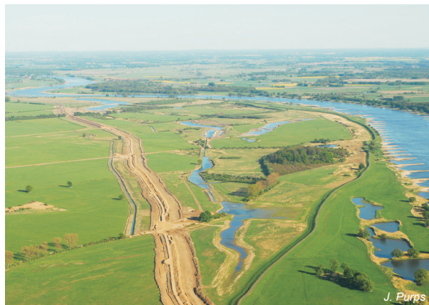
Obr. 4.3-3: Letecký snímek oddálení ochranné hráze u obce Lenzen, km 476,7 – 483,8
